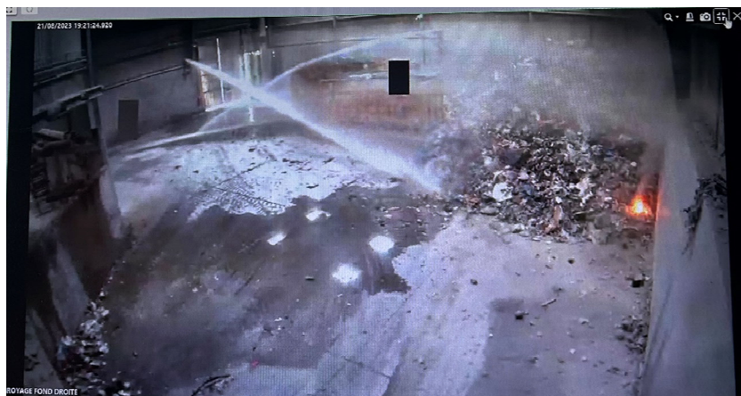
Vue caméra bâtiment broyage fond droite : identification du départ de feu et déclenchement des canons à eau à 19h21
